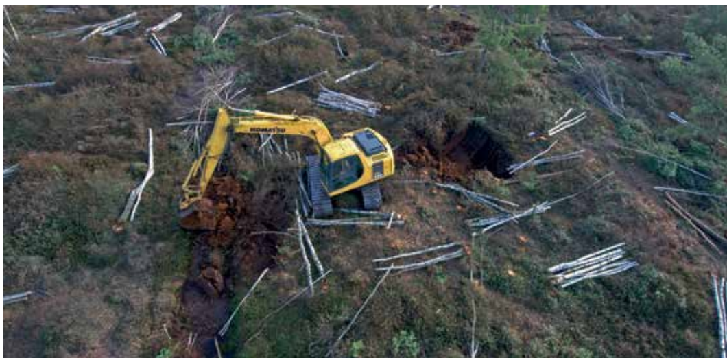
7 pav. Durpinio grunto užtūros įrengimas (M. Sandaro nuotr.)
